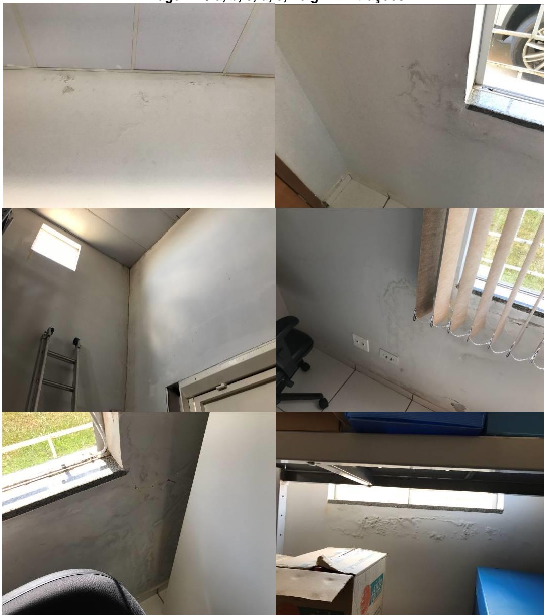
Imagem 15 a, b, c, d, e, f e g – Infiltrações.
