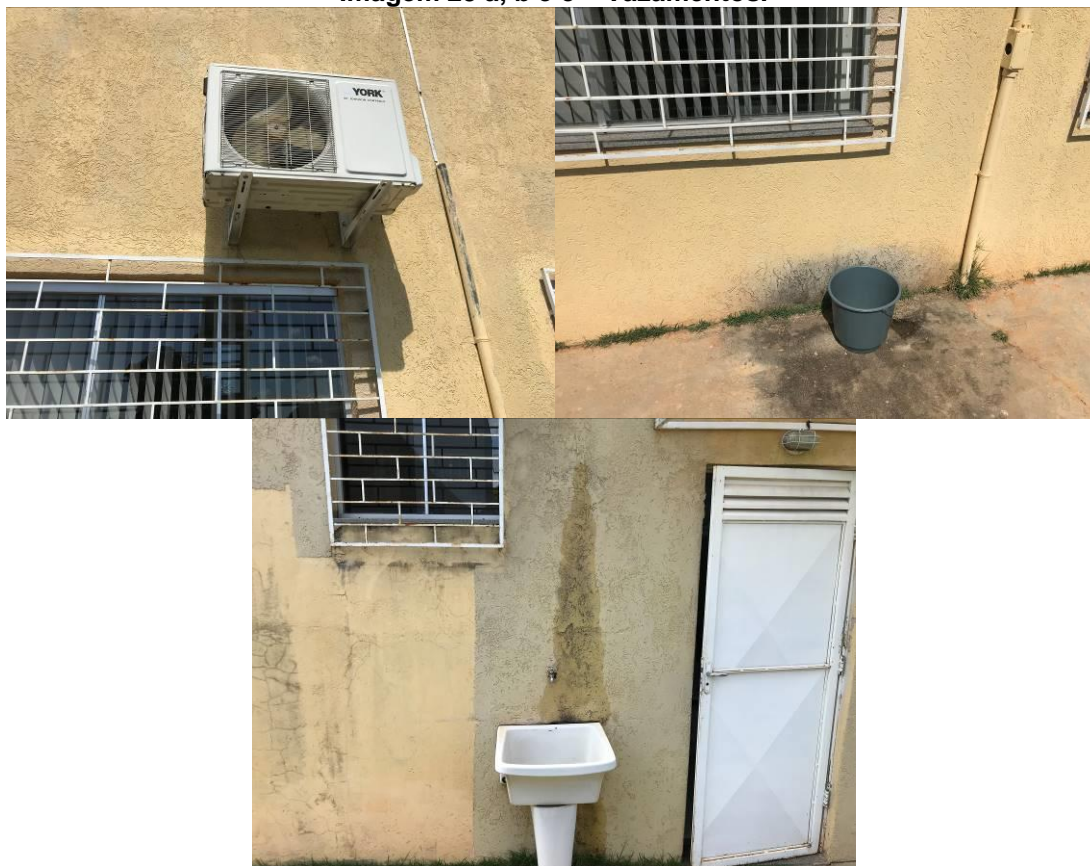
Imagem 23 a, b e c – Vazamentos.
