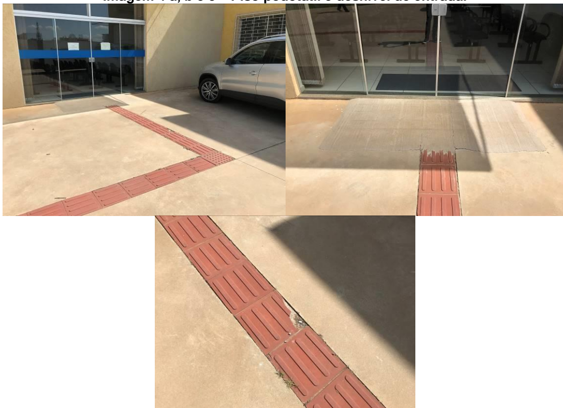
Imagem 4 a, b e c – Piso podotátil e desnível de entrada.
